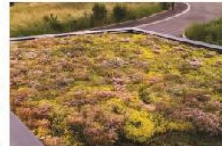
Les toitures végétalisées doivent respecter certaines caractéristiques : épaisseur de substrat minimale, qualité des substrats, diversification des types de végétaux, etc.
